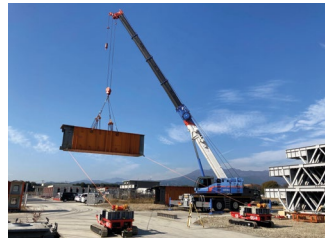
Thiết bị dẫn hướng tải treo bằng dây “EG-Guide”
