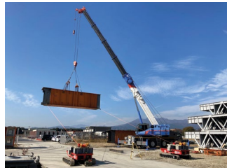
Un dispositivo para guiar cargas suspendidas con cuerdas «EG-Guide»
