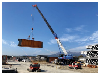
Un dispositif pour guider les charges suspendues avec des cordes « EG-Guide »
