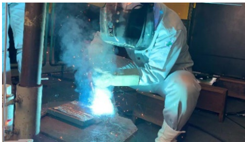
3Dデジタル溶接マスクを用いた溶接
