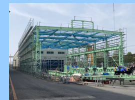
BOXライン増強(栃木工場)
