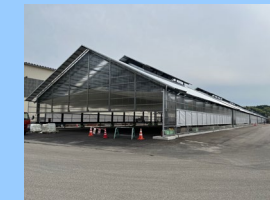
SCデッキ塗装建屋(富山工場)
