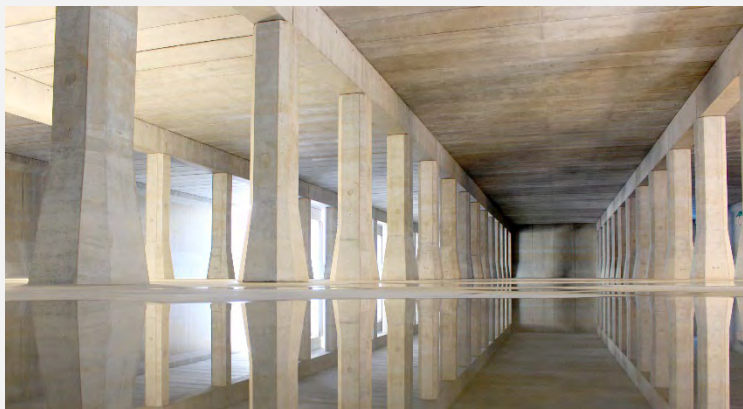
新座大和田雨水貯留槽
