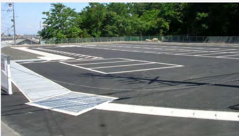
上部を駐車場として利用した例
