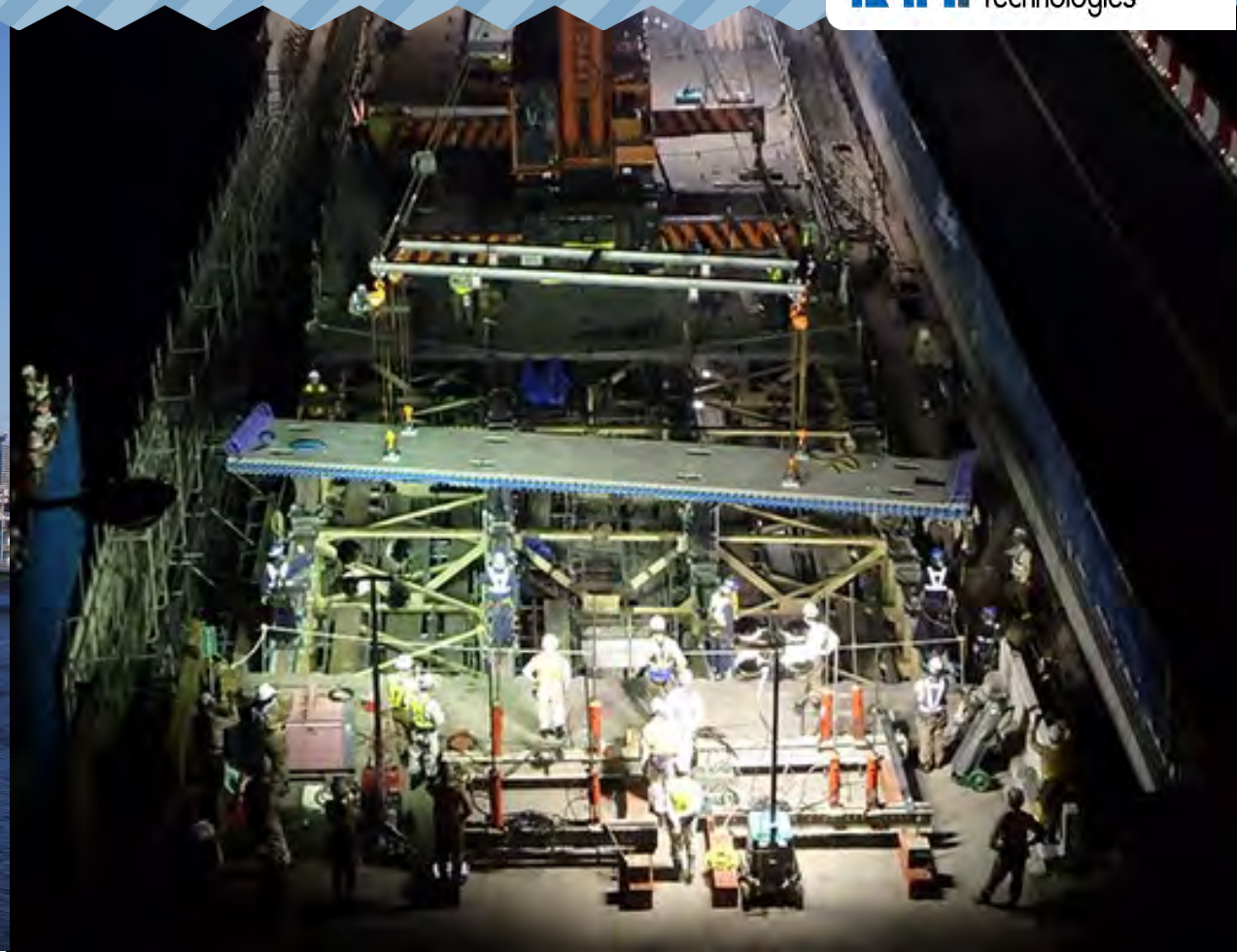
東名高速道路床版取替工事
