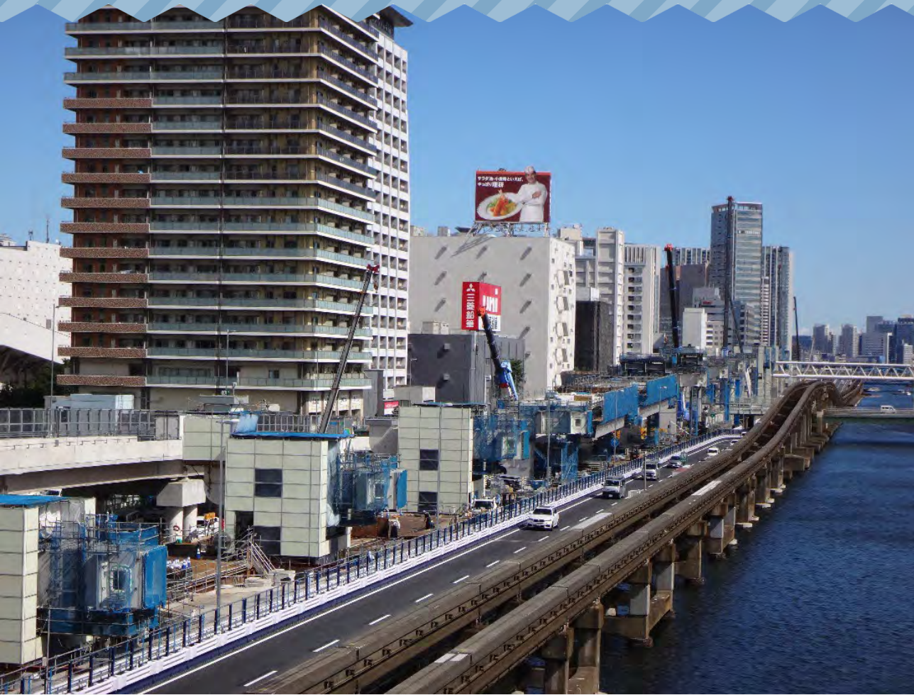
首都高速羽田線更新工事
