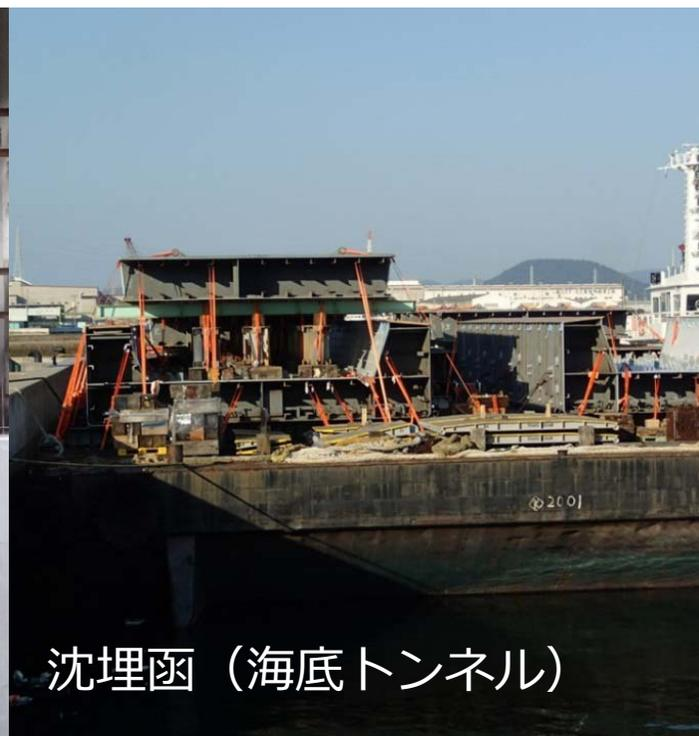
沈埋函（海底トンネル）
