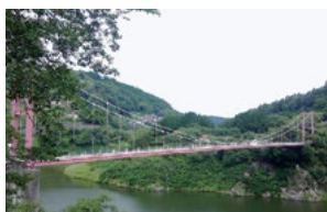
八幡橋（奈良県—京都府 1968年） ストレートの平行線ケーブルを使用したPWS（パラレルワイヤストランド）工法を採用。
