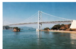
因島大橋（広島県 1983年） 川田工業が補剛桁工事共同企業体代表を務める。架設中にコンピューターを用いた振動試験や応力計測を実施。
