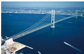
明石海峡大橋(兵庫県 1998年) 橋長3,911m、中央支間長1,991mと当時世界最長を誇る。川田グループ各社が主塔、ケーブル、補剛桁架設、解析計算に参画。
