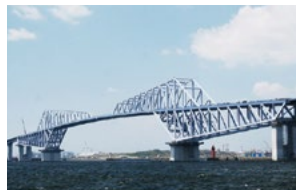
東京ゲートブリッジ (東京都 2010年) 東京港第三航路を跨ぐ中央支間長440m。国内最大級のフローティングクレーン3隻による相吊一括架設を2回行った。
