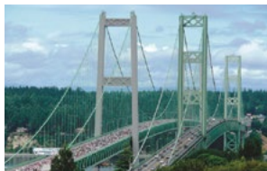
新タコマナローズ橋 (米国ワシントン州 2007年) 中央支間長853m。川田工業が主ケーブルと補剛桁の製作・輸送を行い、現地工事エンジニアリングに参画。
