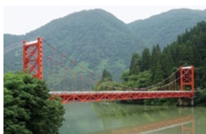
大渡橋（富山県 1958年） 国内吊橋で初めてスパイラルロープを使用（1957年）。
