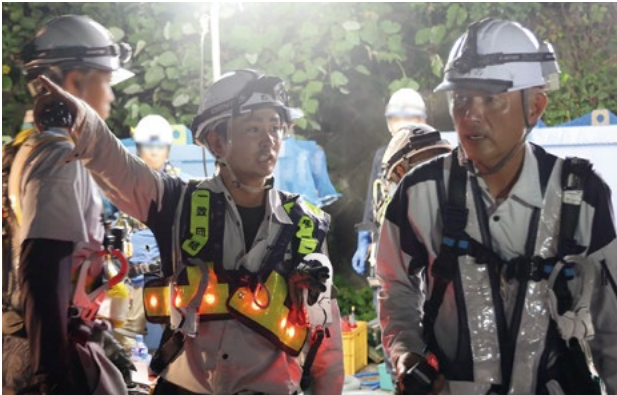
杉谷第2跨道橋撤去工事
