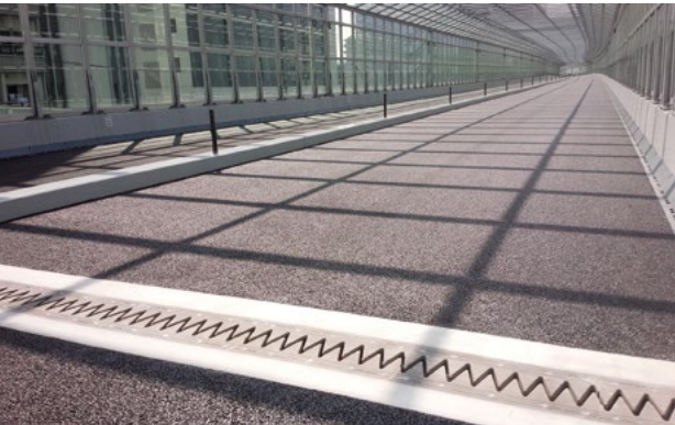
勝どき陸橋に施工された「KMA ジョイント」
