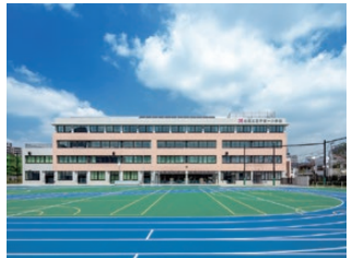
王子第一小学校新築工事 (東京都北区)
