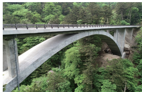
下塩原第一橋梁 (栃木県)
