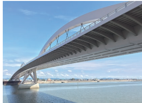
福岡208号 筑後川橋上部工 (P4-P8) 工事 (九州地方整備局)
