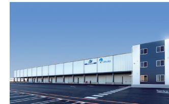
(株)ラックサービス中部ロジスティクスセンター新築工事(愛知県)
