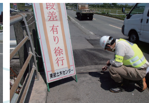
間島橋（熊本市東区）の調査
