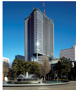
(仮称)新日比谷プロジェクト新築工事(東京都)
