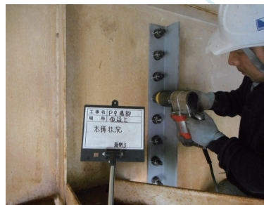
鋼桁の補強
