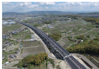
京田辺高架橋(京都府)
