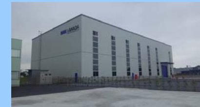
関東機材センター建設
