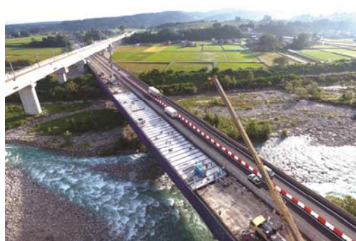
早月川橋床版更新工事
