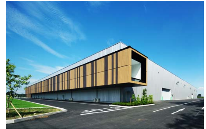
アイダ設計 プレカット事業部 茨城工場新築工事
