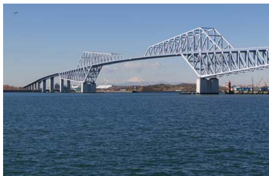
東京ゲートブリッジ
