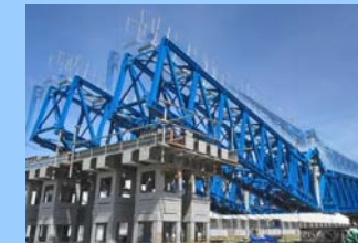
架設機材改良(手延べ機)
