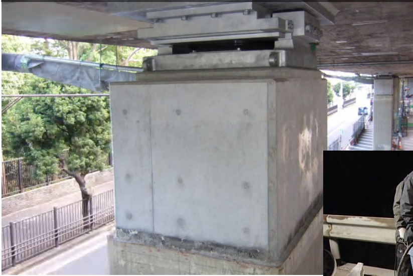
桁のFRP補修・強化
