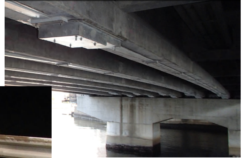
桁のFRP補修・強化
